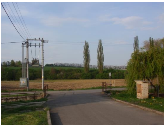
Stávající trafostanice u plochy BI č. 3
